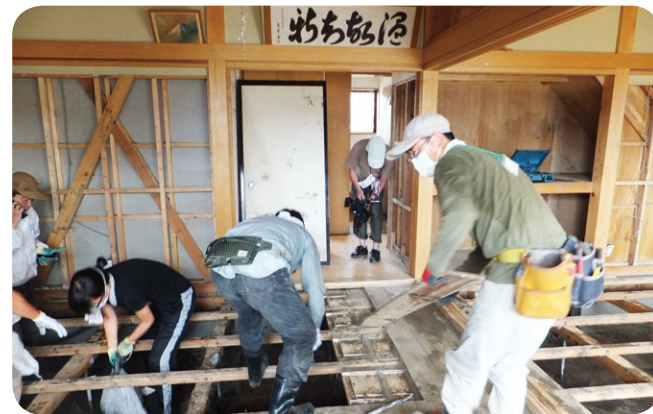
床板をすべて剥がし、床下一面に溜まったヘドロを取り出し、海水に浸かった1階部分の壁も剥がしました。
